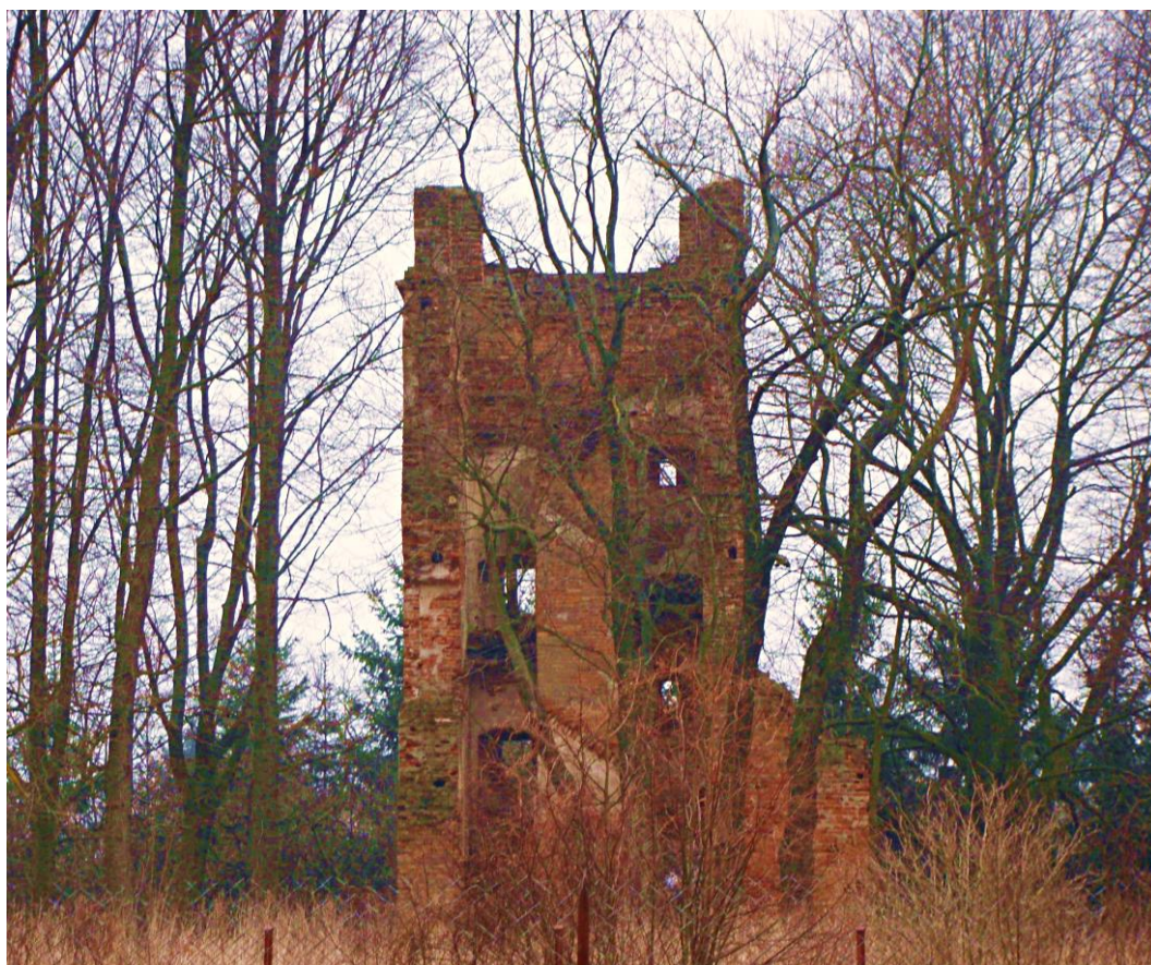
Ilustracja 16. Jesień 2021 r. Ruiny wieży widokowej brokowskiego zamku – jedynej zachowanej do obecnych czasów części budowli.
