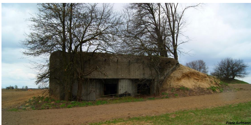
Ilustracja 56. Zambrowski Rejon Umocniony, okolice wioski Zaruzie – jednokondygnacyjny schron do ognia bocznego na dwa ckm-y i rkm ze zredukowanym zapleczem i częścią socjalną. Źródło: Franz Aufmann, Linia Molotowa – umocnienia na nowej granicy państwowej ZSRR , na portalu hauba.pl .
