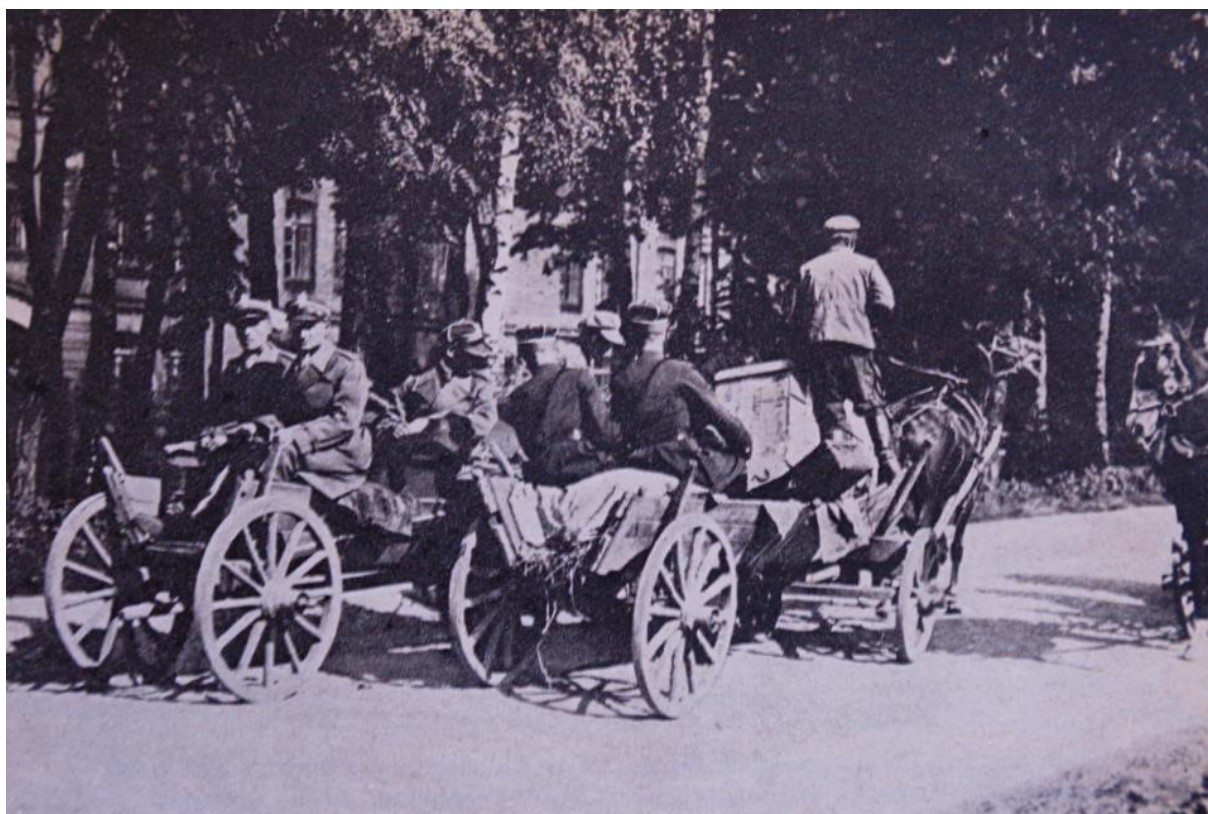
„Jadziem Panie Poruczniku”, czyli regularna komunikacja na trasie SPP w Komorowie – stacja kolejowa 5 .
